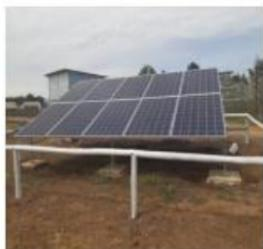
**Paneles Fotovoltaicos:** se deben limpiar los paneles para eliminar restos de hojas, polvo y excremento de aves y animales. Se recomienda utilizar abundante cantidad de agua, sin la adición de detergentes. Es importante que esta limpieza se realice con los paneles fríos para evitar daños. Es necesario realizar esta limpieza semanalmente.
