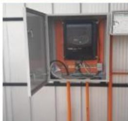
**Inversor:** se debe verificar que el área en donde se encuentra instalado el inversor se encuentre limpia, seca, bien ventilada y que no este invadida por algún tipo de insecto. Si existe mal funcionamiento del inversor, se calentará innecesariamente y se traducirá en una pérdida de rendimiento.
